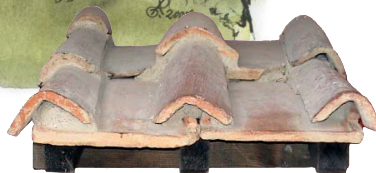
Die Dächer der römischen Gebäude waren mit Ziegeln gedeckt. Typisch sind die großen Ziegelplatten (ca. 30 – 40 cm) mit den Seitenleisten (tegulae), die auf die flachen Dächer gelegt wurden. Die aneinanderstoßenden Leisten der Ziegelplatten wurden mit Holzriegeln (imbrices) abgedeckt.
